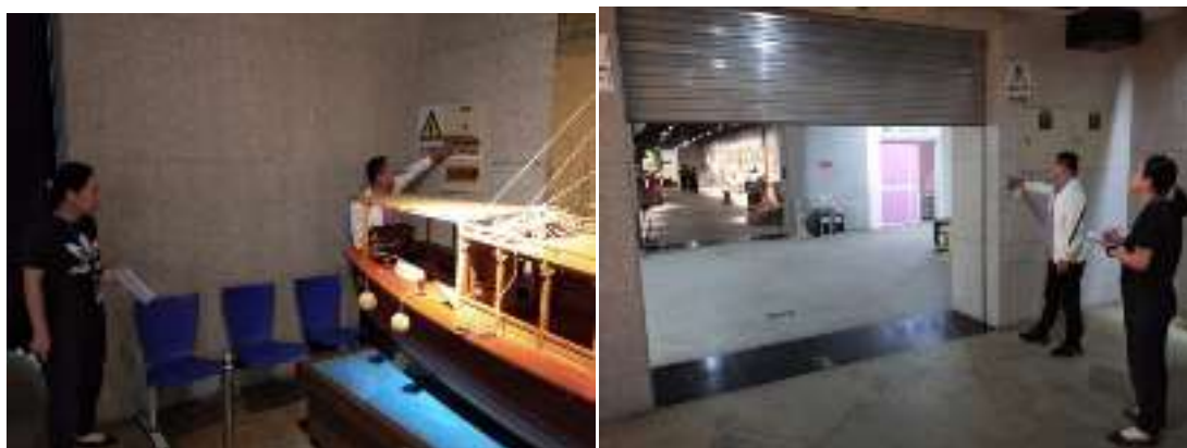
10月4日对消火栓、灭火器、开关、防火卷帘门检查
