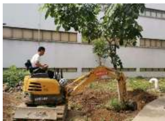
石刻临时库房施工中
