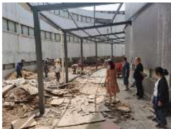
6月21日临时库房工地检查
