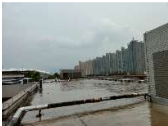
2021.6.14 屋面防水检查
