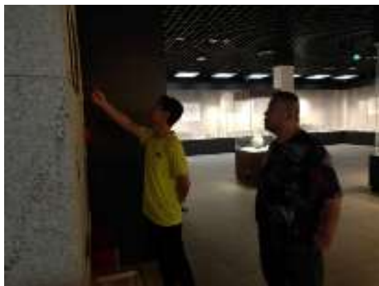
2021.6.20 展厅用电检查
